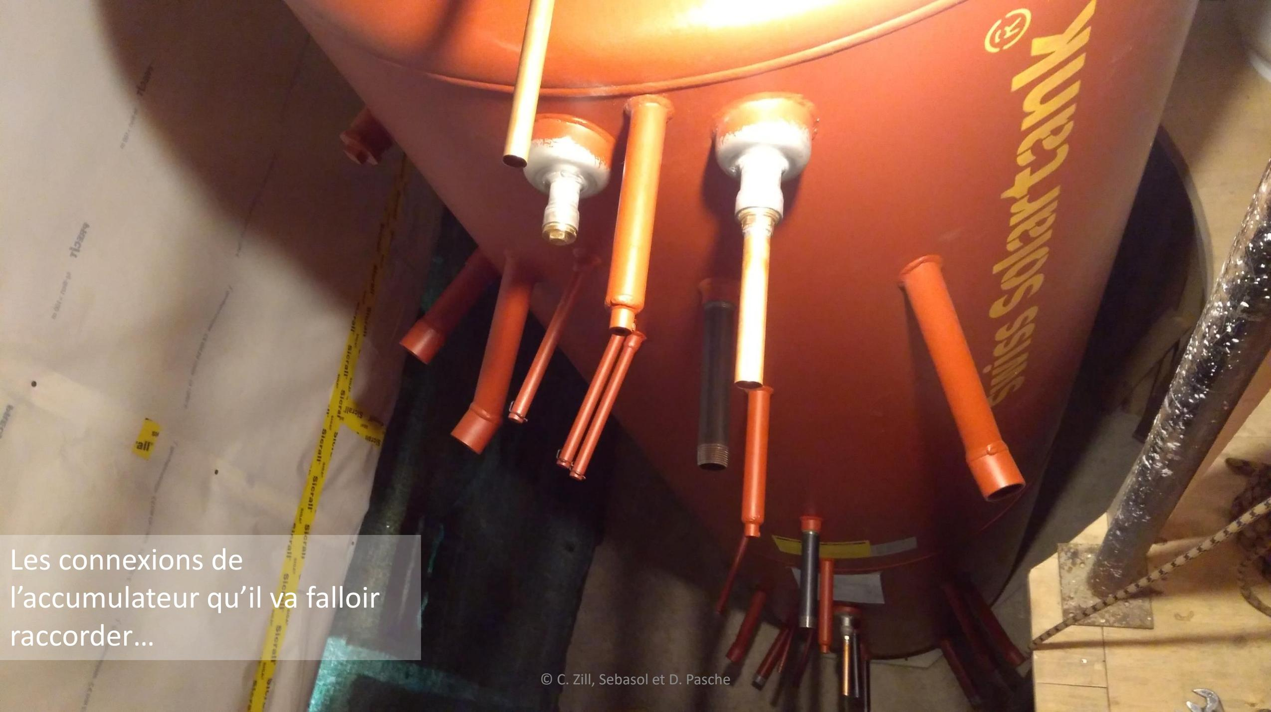
Les connexions de l'accumulateur qu'il va falloir raccorder...
